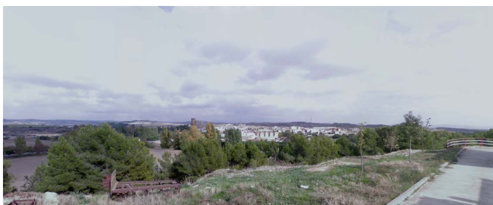
Imágenes de zonas afectadas por deslizamientos
